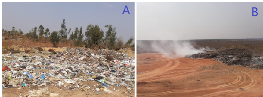
Figura 2. Aterro controlado de Kuito: (A) resíduos sólidos expostos a céu aberto; (B) queima espontânea dos resíduos sólidos
