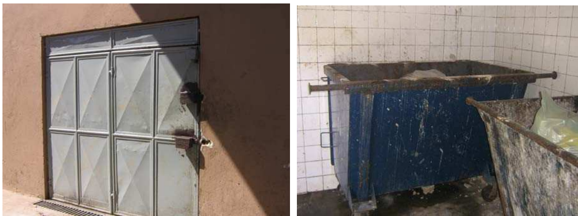
Figura 7 - Acondicionamento de Resíduos no Bompreço - Brotas
